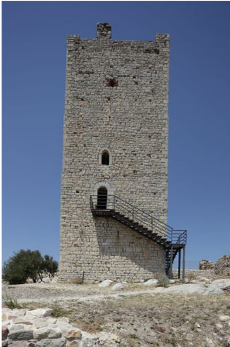
Abb. 4 - Der Turm der Fava-Burg mit dem Eingang oberhalb der Ebene des Waffenplatzes (Foto von Unicity S.p.A.).
