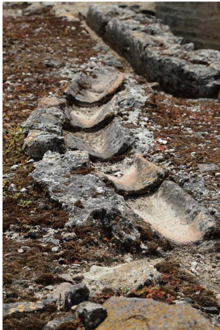
Abb. 1 - Detail eines Kanals aus Dachziegeln (Foto von Unicity S.p.A.).
