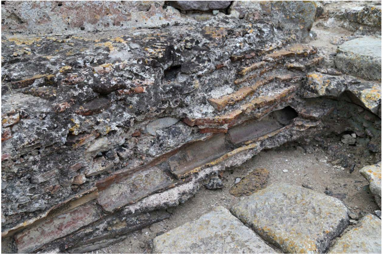
Abb. 3 - Leitung, die ursprünglich in einer Mauer verlief (Foto von Unicity S.p.A.).
