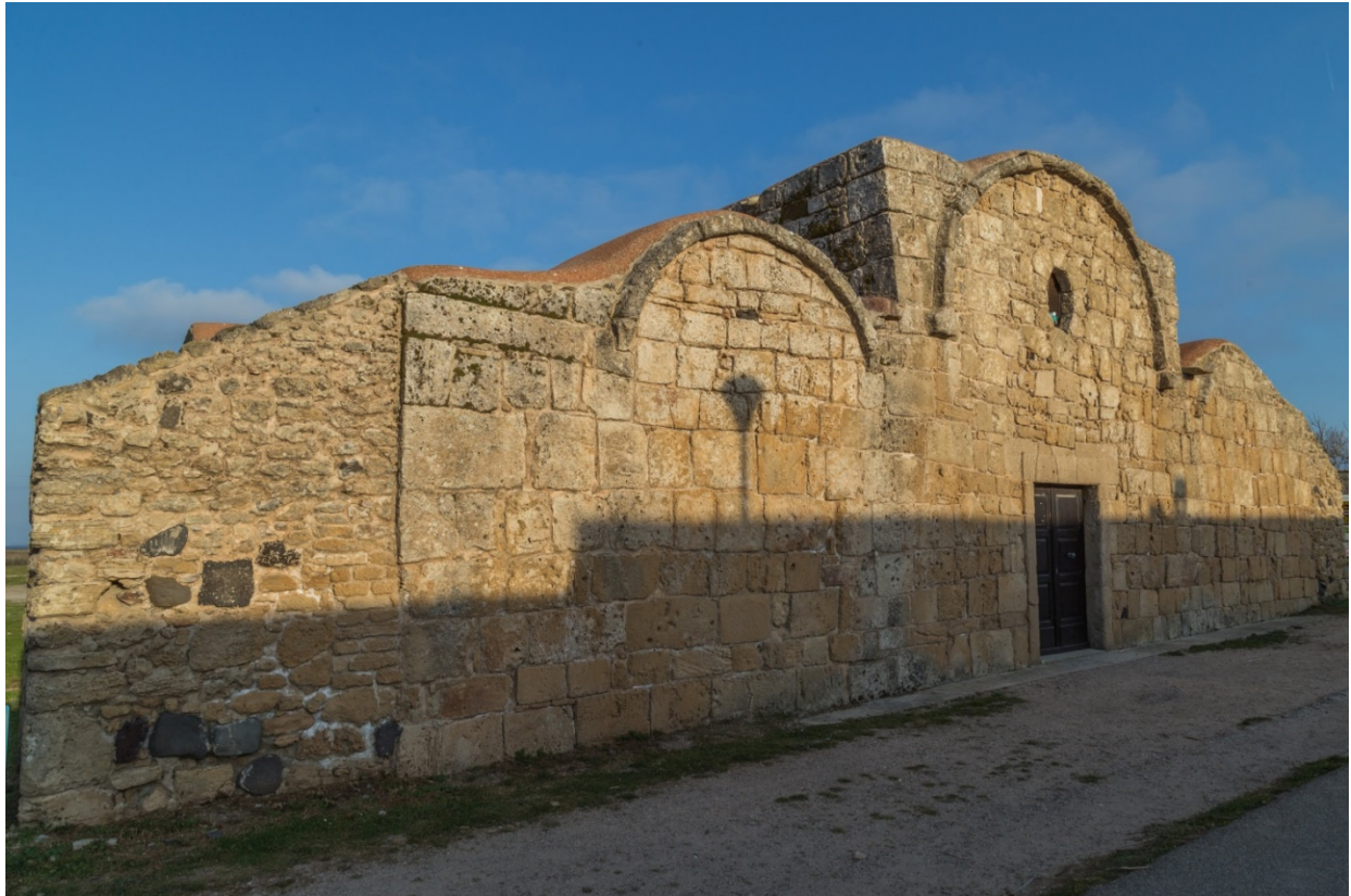
Abb. 6 - Fassade der Kirche San Giovanni (Foto von Unicity S.p.A.)
