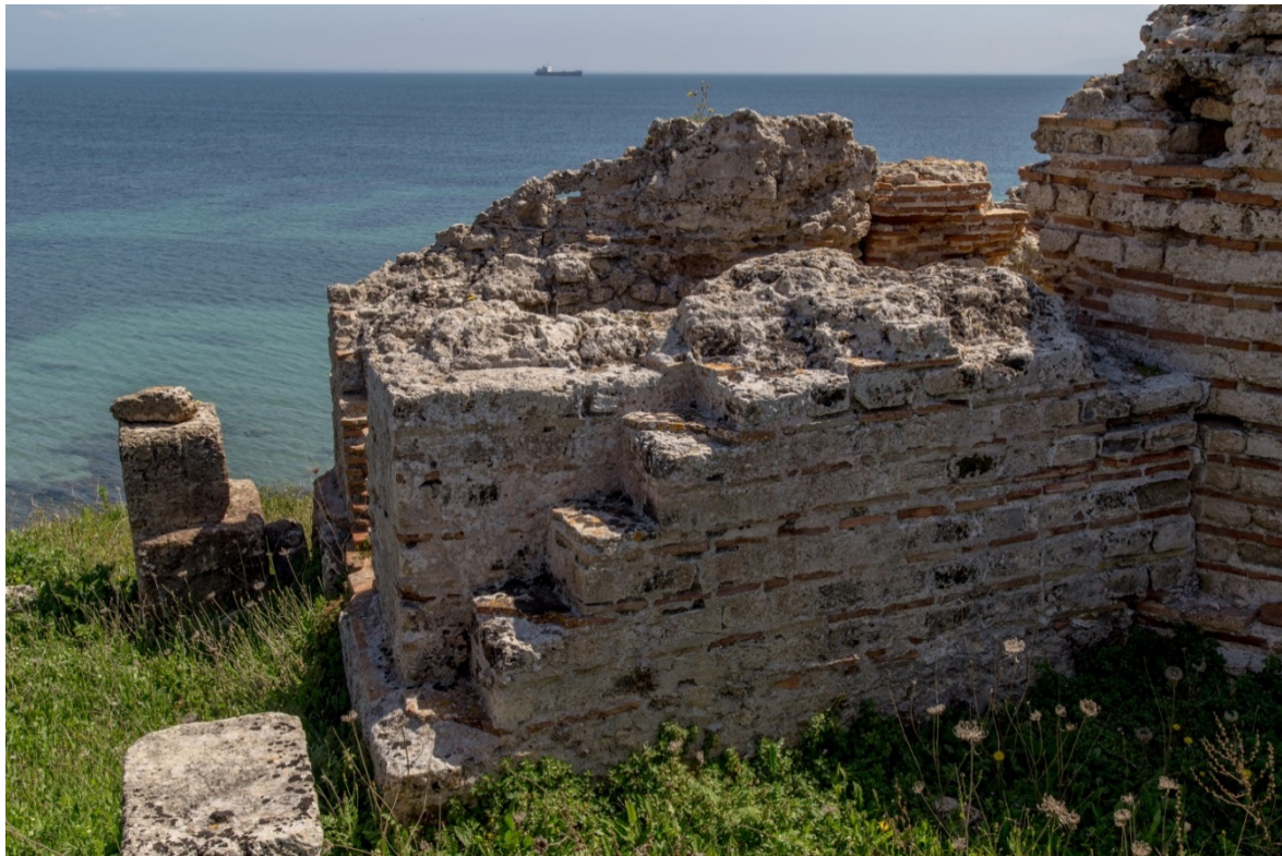
Abb. 9 - Das Äußere eines beheizten Raums, mit Treppe für den Zugang zu den Zisternen auf dem Dach des Gebäudes (Foto von Unicity S.p.A.)
