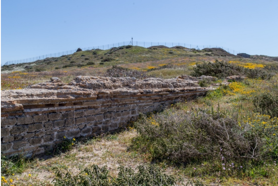
Abb. 2 - Der Aquädukt; im Hintergrund der Hügel Su Muru Mannu (Foto von Unicity S.p.A.)
