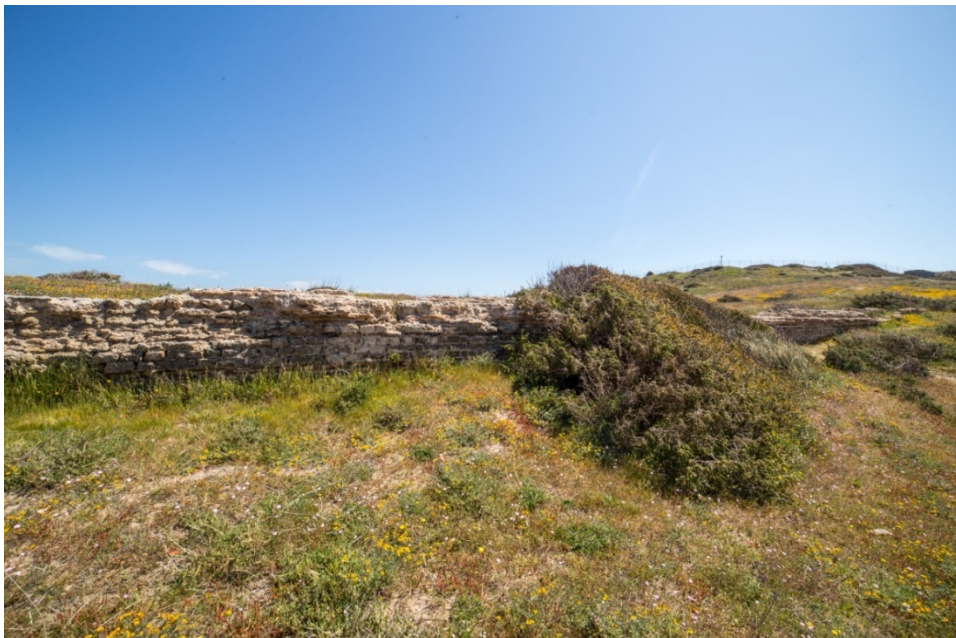
Abb. 3 - Abschnitt des Aquädukts (Foto von Unicity S.p.A.)
