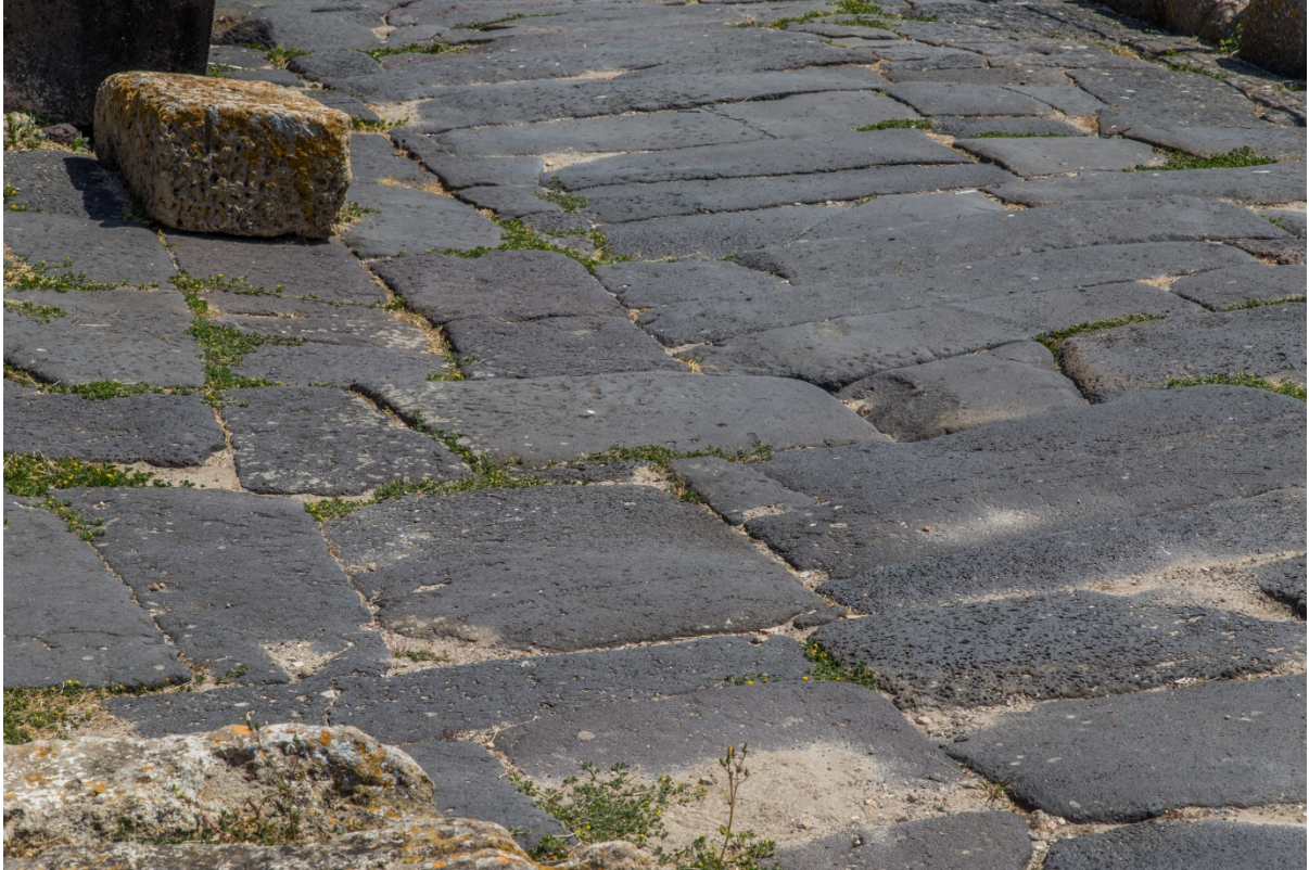
Abb. 5 - Pflasterung einer Straße (Foto von Unicity S.p.A.)
