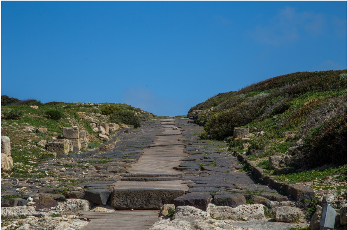
Abb. 3 - Große Straße mit verlauf von Norden nach Süden; in der Mitte die römische Kanalisation, zurzeit aus Sicherheitsgründen mit Holz abgedeckt (Foto von Unicity S.p.A.)
