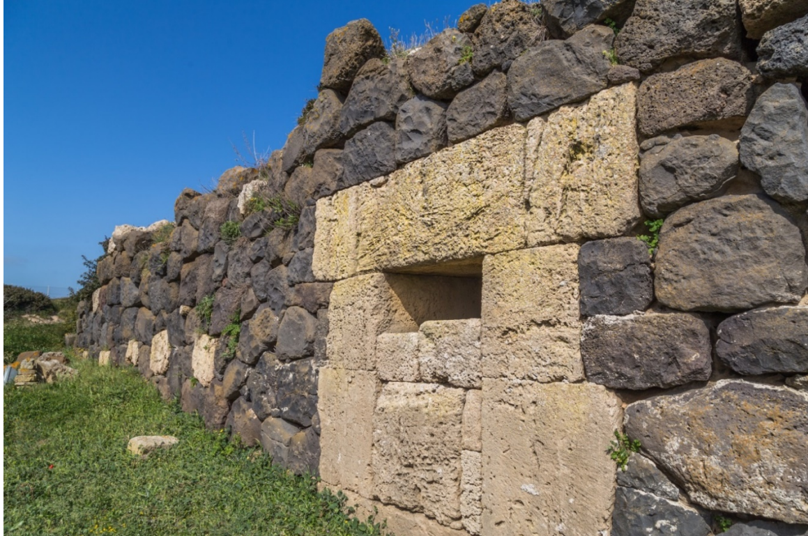
Abb. 2 - Ringmauer der Befestigung, mit einer in späterer Zeit verschlossenen Öffnung (Foto von Unicity S.p.A.)
