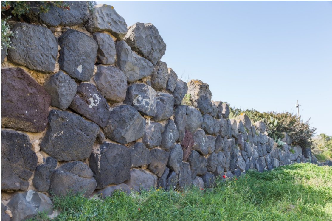
Abb. 3 - Die Böschungsmauer der Befestigung (Foto von Unicity S.p.A.)
