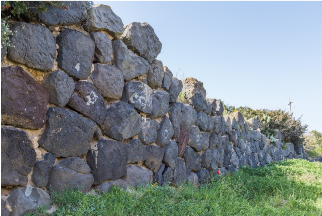
Abb. 7 - Die Böschungsmauer (Foto von Unicity S.p.A.)
