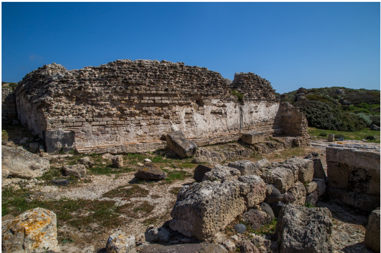
Abb. 20 - Das Fassade des Castellum Aquae mit dem öffentlichen Brunnen (Foto von Unicity S.p.A.)
