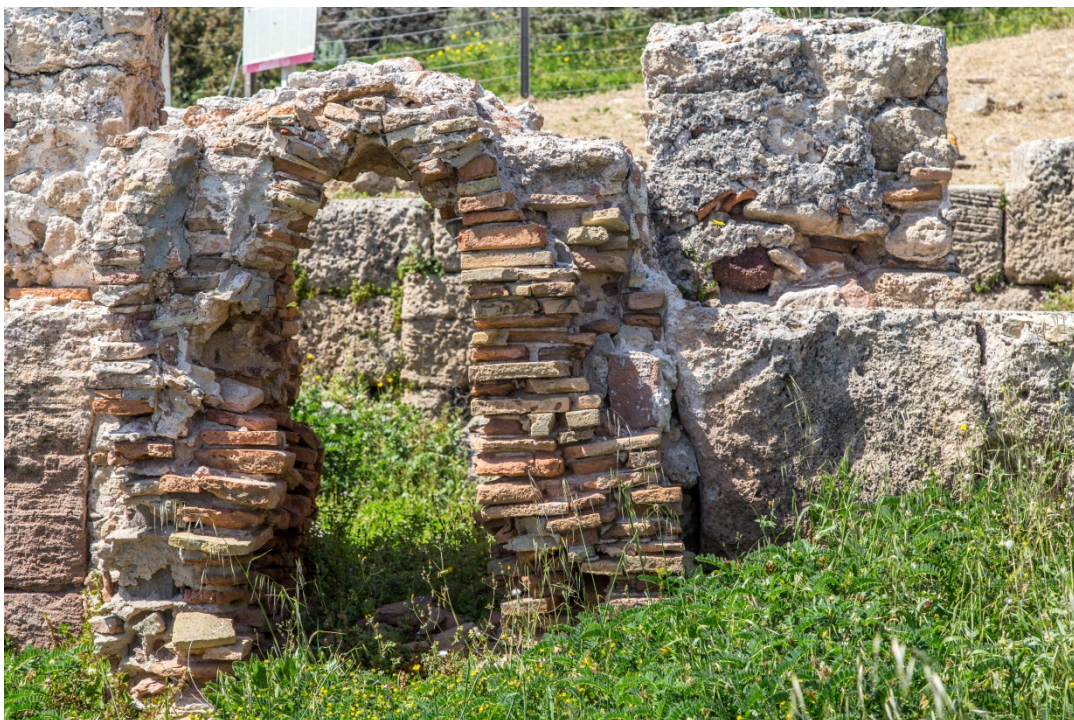
Abb. 30 - Thermen Nr. 1: Öffnung eines Praefurniums (Foto von Unicity S.p.A.)
