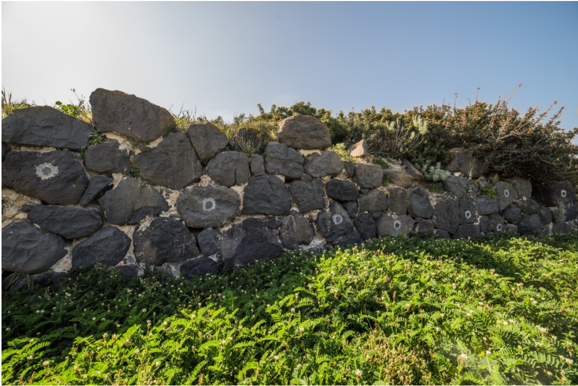
Abb. 11 - Die Böschungsmauer des Grabens (Foto von Unicity S.p.A.)
