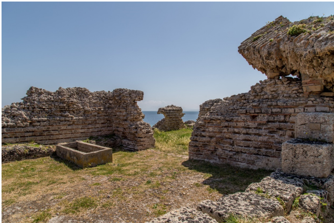
Abb. 33 - Die Umkleide der Thermen des alten Konvents mit Eingang zum Frigidarium, und links das byzantinische Grab, das in ein modernes Bauwerk aus Beton integriert ist (Foto von Unicity S.p.A.)
