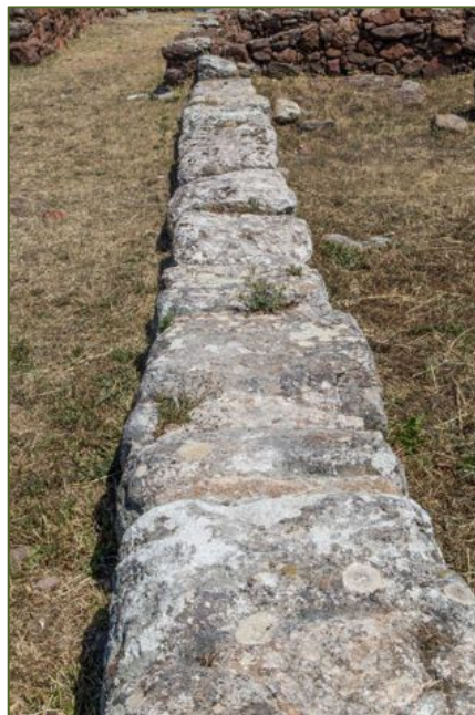
Abb. 7 - Tragende Mauer aus opus quadratus (Foto von Unicity S.p.A.).
