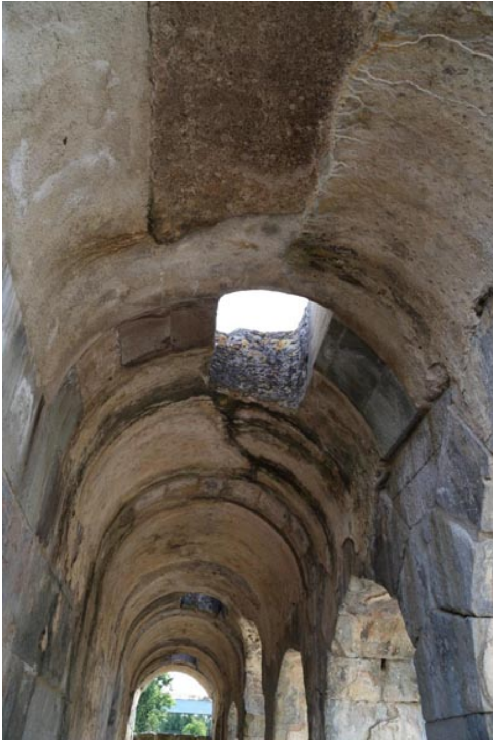
Abb. 5 - Überdachung des Portikusses mit den Oberlichtern für die Beleuchtung (Foto von Unicity S.p.A.).
