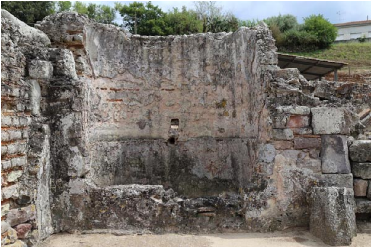
Abb. 3 - Halbrundes Tauchbecken (Foto von Unicity S.p.A.).
