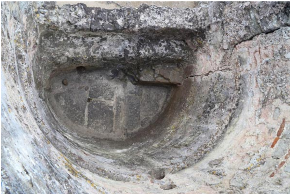
Abb. 4 - Detail des Beckens mit Zugangstufen (Foto von Unicity S.p.A.).
